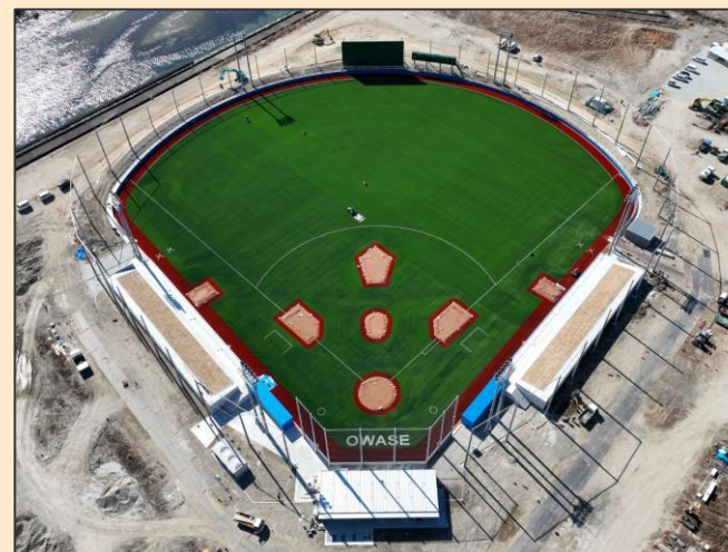
野球場建設工事
