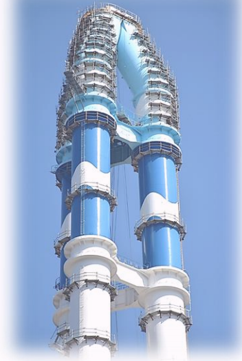
※煙突の先端に足場が組まれています
